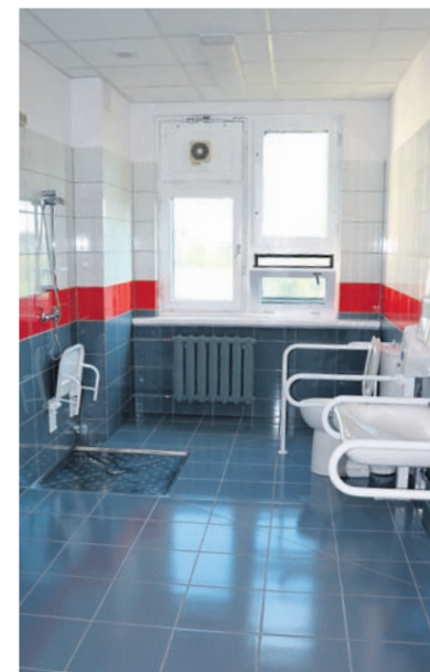
Remont obejmował między innymi modernizację łazienek.
