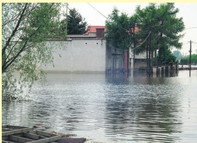
Dawny magazyn przeciwpowodziowy tuż po ustąpieniu fali powodziowej.
