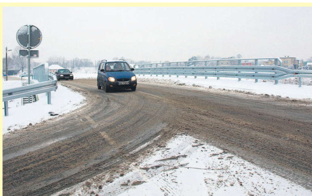
Mimo okrywającego most śniegu widać szerszą jezdnię, chodnik, zapewniające większe bezpieczeństwo bariery.
