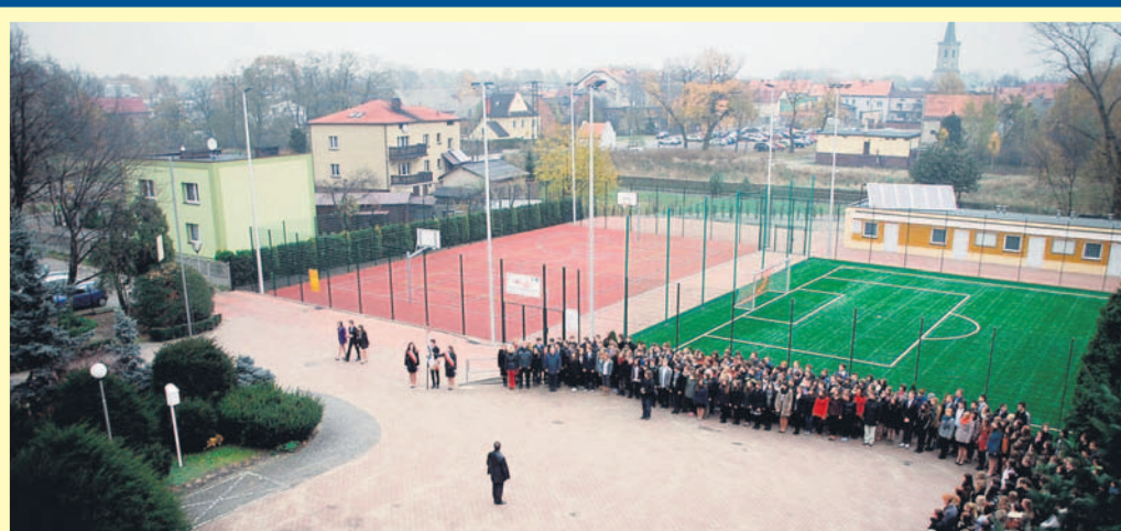
Tak prezentuje się orlik z lotu ptaka. Zdjęcie wykonano podczas szkolnego apelu. Widać dwa boiska, szatnię z solarami podgrzewającymi wodę, maszty z lampami oświetlającymi teren.
