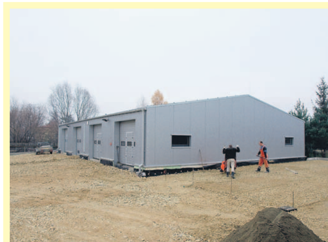
Na budowie nowej siedziby PZD i magazynów.
