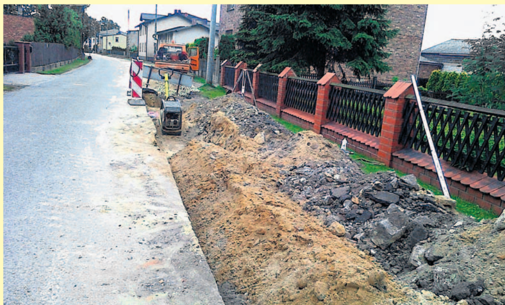
Remont ul. Odrodzenia w Chelmie Śląskim.
