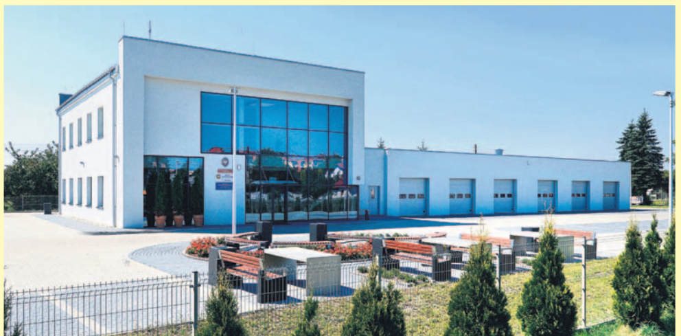
Budowa budynku Powiatowego Zarządu Dróg w Bieruniu wraz z magazynami przeciwpowodziowymi kosztowała 3.840.759,60 zł.
