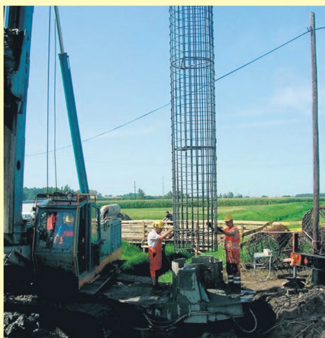
Palowanie mostu w ciągu ulicy Zamkowej w Łędzinach.
