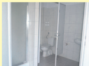
Nowoczesne zaplecze sanitarne...
