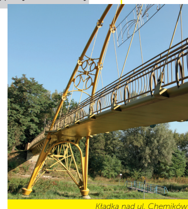
Kładka nad ul. Chemików
